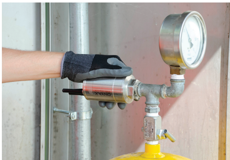
Dispositivo TUBE-T3 per monitoraggio pressioni e vibro-acustica in rete gas
