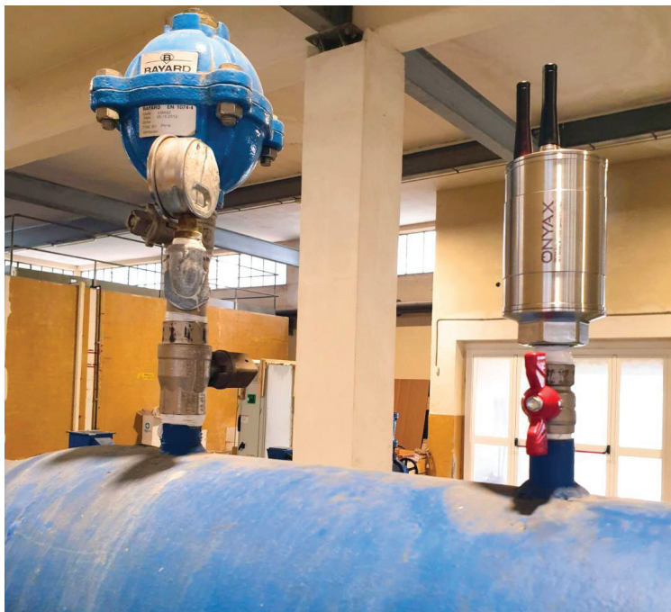
Analisi pressoria, vibrazionale e acustica su stazione di pompaggio idrico
